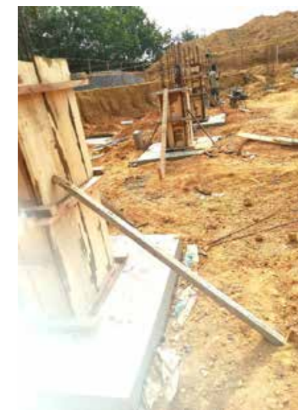
Si lavora alle fondazioni.
